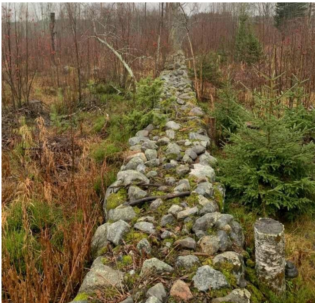
Befintlig mur väster om planområdet (hösten 2022).
